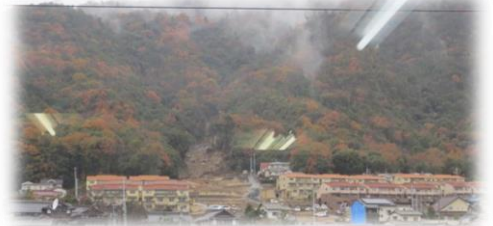
よつば幼稚園3Fより被災地を撮影
